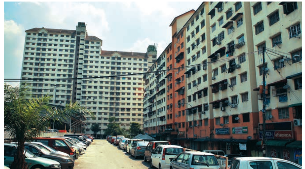
Taman Bukit Angkasa Flats
